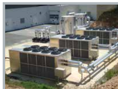
enfriadores de proceso de alta capacidad
